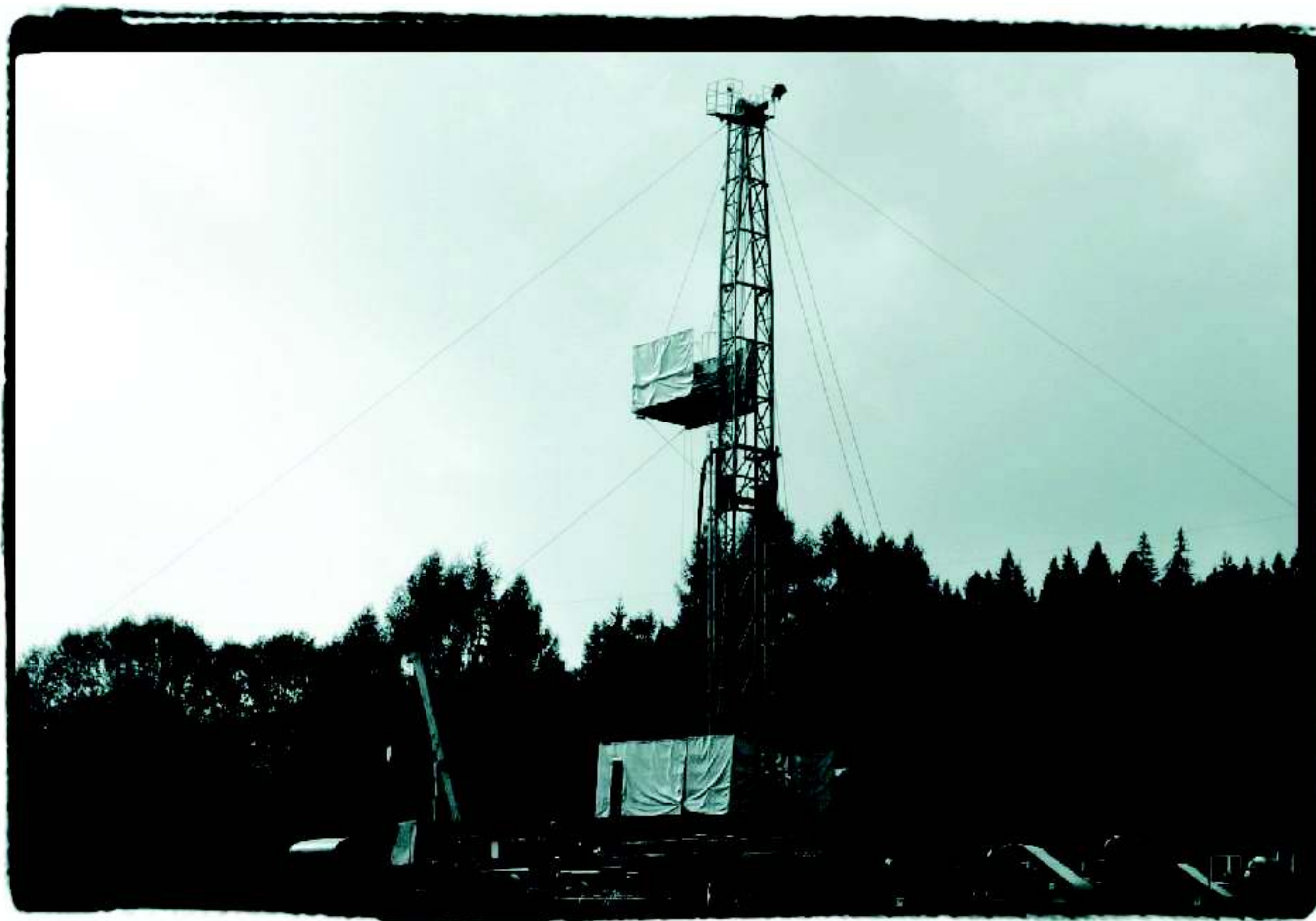
Wieża wiertnicza (odwiert geotermalny) 26 września 2006 rok
