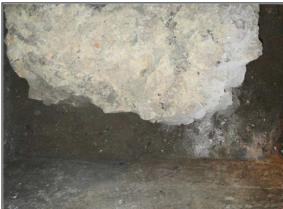
Fot. nr 5. Kraków, ul. św. Marka 35, relikw muru w pomieszczeniu piwnicznym w trakcie frontowym, strzypie południowe, widok ogólny, stan obecny. Fot. M. Goras 2017 r.
