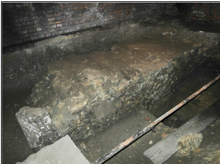
Fot. nr 8. Kraków, ul. św. Marka 35, relikw muru w pomieszczeniu piwnicznym w trakcie tylnym, widok od zachodu, stan obecny. Fot. M. Goras 2017 r.
