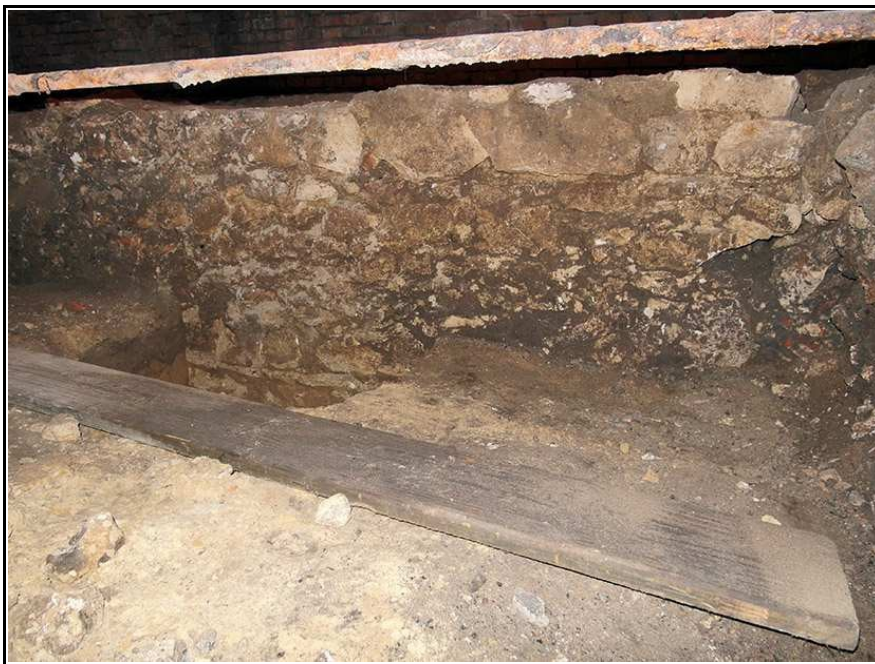
Fot. nr 12. Kraków, ul. św. Marka 35, relikw muru w pomieszczeniu piwnicznym w trakcie tylnym, widoczne lico muru w wykopie archeologicznym, z czytelnym rzędowaniem wstku kamiennego. Fot. M. Goras 2017
