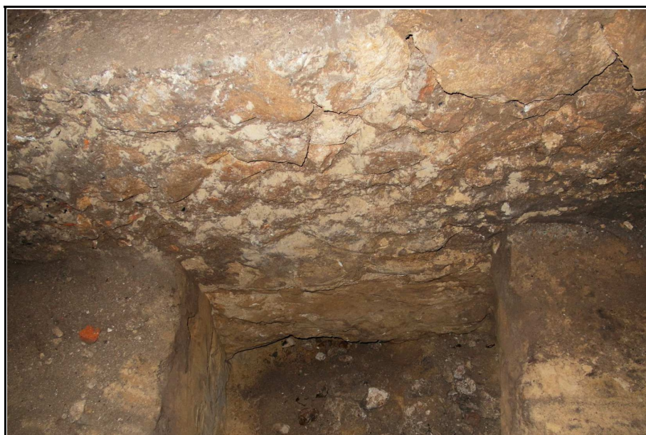
Fot. nr 11. Kraków, ul. św. Marka 35, relikw muru w pomieszczeniu piwnicznym w trakcie tylnym, widok od zachodu, stan obecny; widoczny układ warstwowy muru. Fot. M. Goras 2017 r.
