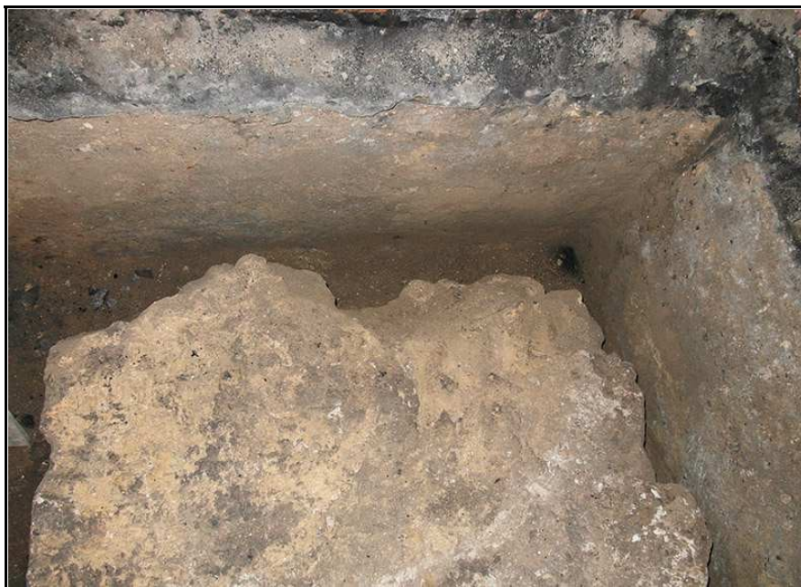
Fot. nr 4. Kraków, ul. św. Marka 35, relikw muru w pomieszczeniu piwnicznym w trakcie frontowym, strzypie północne, widok ogólny, stan obecny. Fot. M. Goras 2017 r.
