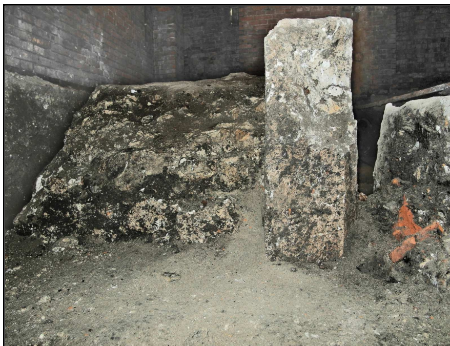
Fot. nr 9. Kraków, ul. św. Marka 35, relikw w pomieszczeniu piwnicznym w trakcie tylnym; w narożniku widoczny fragment kamieniarki z częściowo zachowanym śladem fazowania od strony północnej, stanowiący zapewne fragment węgara d. wejścia w zachowanym licu muru. Fot. M. Goras 2017 r.
