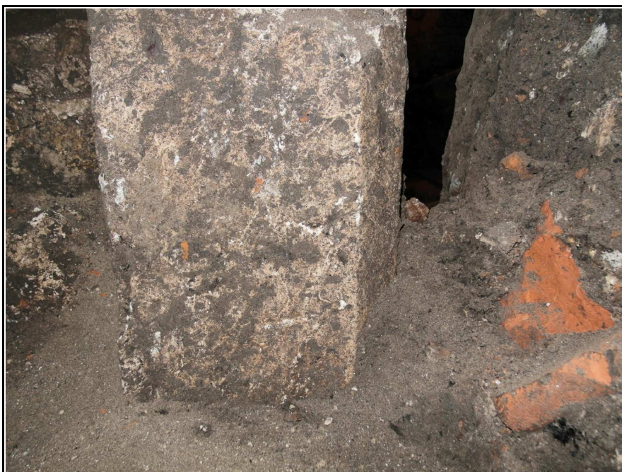
Fot. nr 10. Kraków, ul. św. Marka 35, relikw muru w pomieszczeniu piwnicznym w trakcie tylnym, czytelne fazowanie fragmentu kamiennego obramienia otworu. Fot. M. Goras 2017 r.
