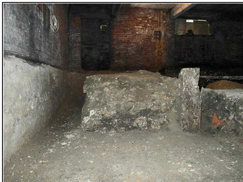
Fot. nr 7. Kraków, ul. św. Marka 35, relikw muru w pomieszczeniu piwnicznym w trakcie tylnym; z prawej widoczny fragment kamieniarki z częściowo zachowanym śladem fazowania, stanowiący zapewne fragment węgara d. wejścia. Fot. M. Goras 2017 r.
