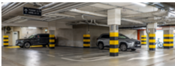
Podziemny garaż na 150 samochodów
