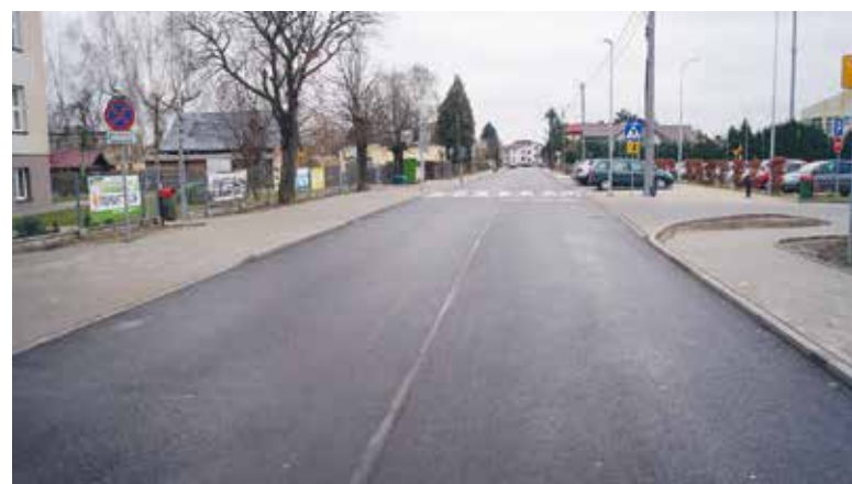
W zeszłym roku zrealizowano przebudowę kilku przejść dla pieszych w Czernikowie. Obecnie trwają prace na ul. Akacyjowej.
