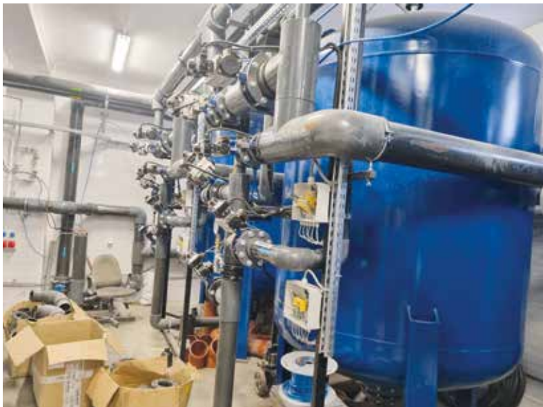
Do marca 2022 r. ma zakończyć się budowa wraz z rozbudową stacji uzdatniania wody w Siemoniu. To zadanie strategiczne dla zabezpieczenia w wodę pitną mieszkańców północnej części gminy.
