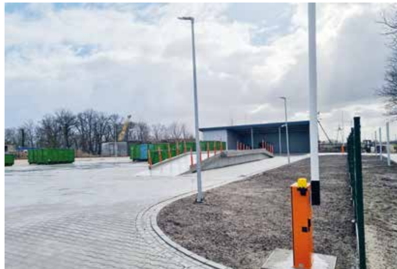
Jesienią 2021 r. zakończyła się budowa nowego punktu selektywnego zbierania odpadów komunalnych w Rzęczkowie.
