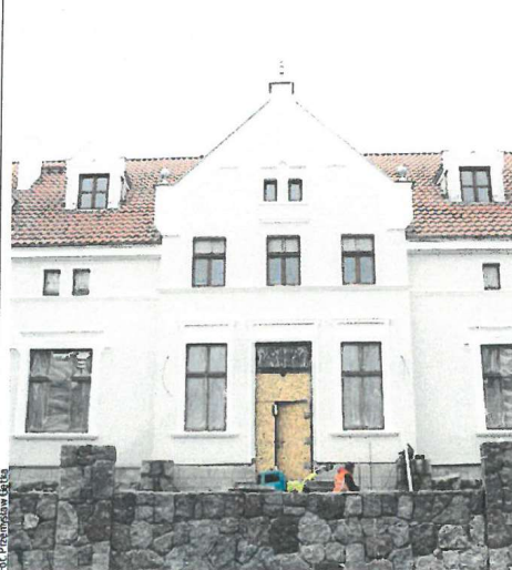
Pałac we wsi Mortęgi, w którym aktualnie trwają prace remontowe. Historyczna fasada jest już odnowiona
